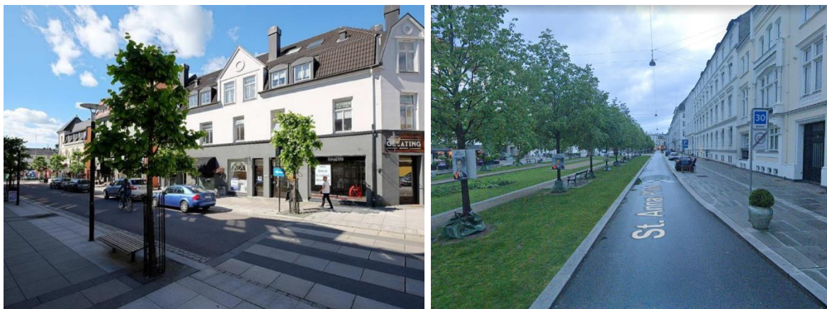
Figur 18: Til venstre, eksempel på oppstrammet veigeometri, parkering, møbleringssone og beplantning i Sandefjord (Civitas, 2020). Til høyre, eksempel på breie fortau, integrerte løsninger for korttidsparkering eller beplantning i København (Google Streetview, 2020).
